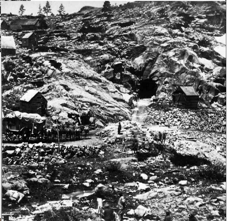
Alfred A. Hart 199 E. Portal Tunnel 6
